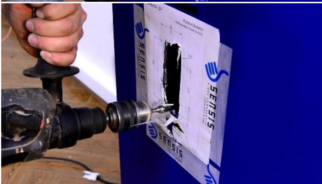
Рис 15-16. Выравниваем отверстие по контуру
