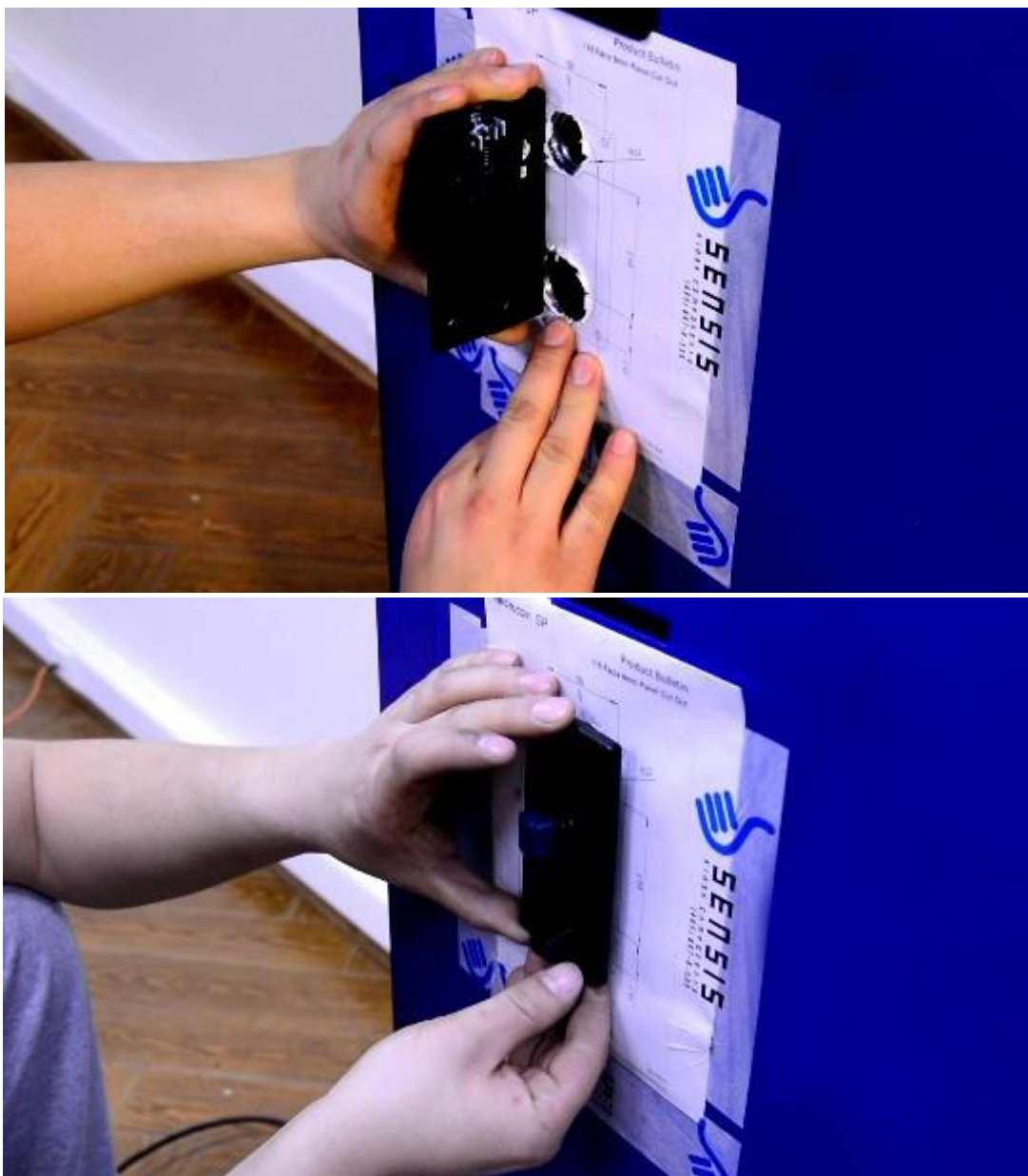
Рис.10-11 Предварительная примерка монетоприемника Microcoin SP
