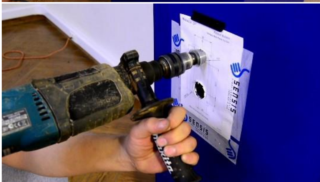
Рис.7-8 Сверлим второе отверстие по контуру чертежа
