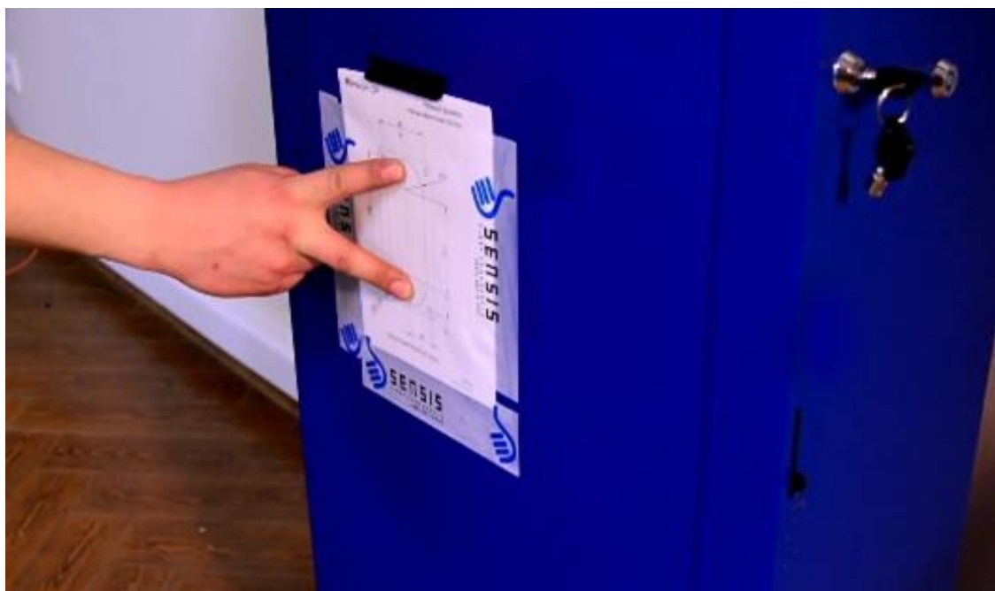
Рис.4 Данная схема поможет точно разметить зону монтажа
